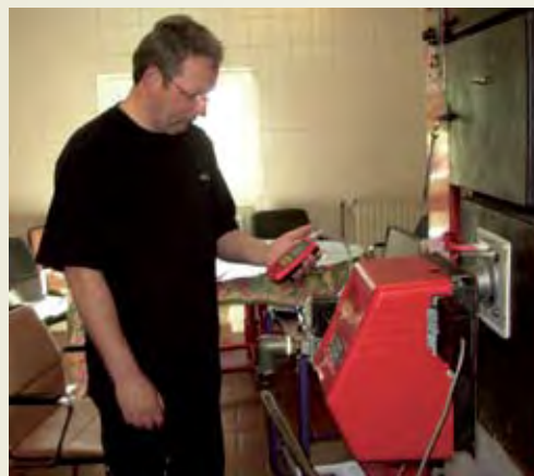
Рис.3 Монтаж и наладка параметров горелки
